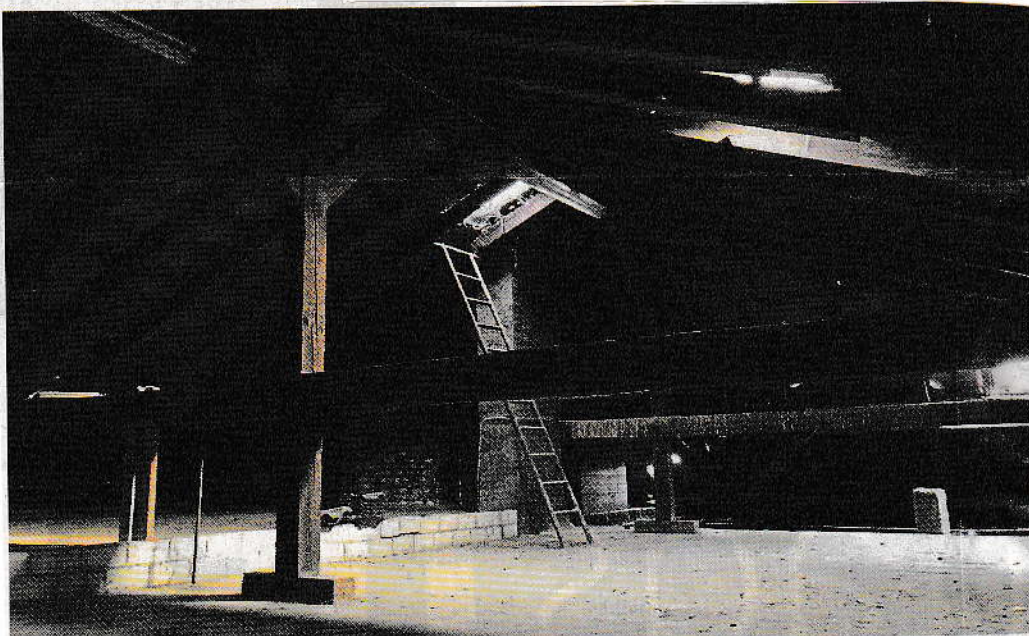
Unter anderem das Dach, das beim Wiederaufbau als Notkirche 1948 konstruiert wurde, soll komplett saniert und auf den neuesten Stand gebracht werden.
